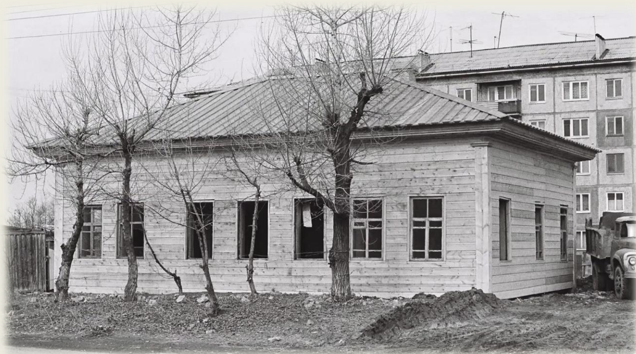
Завершение реставрационных работ в доме декабриста. 1996 г.
