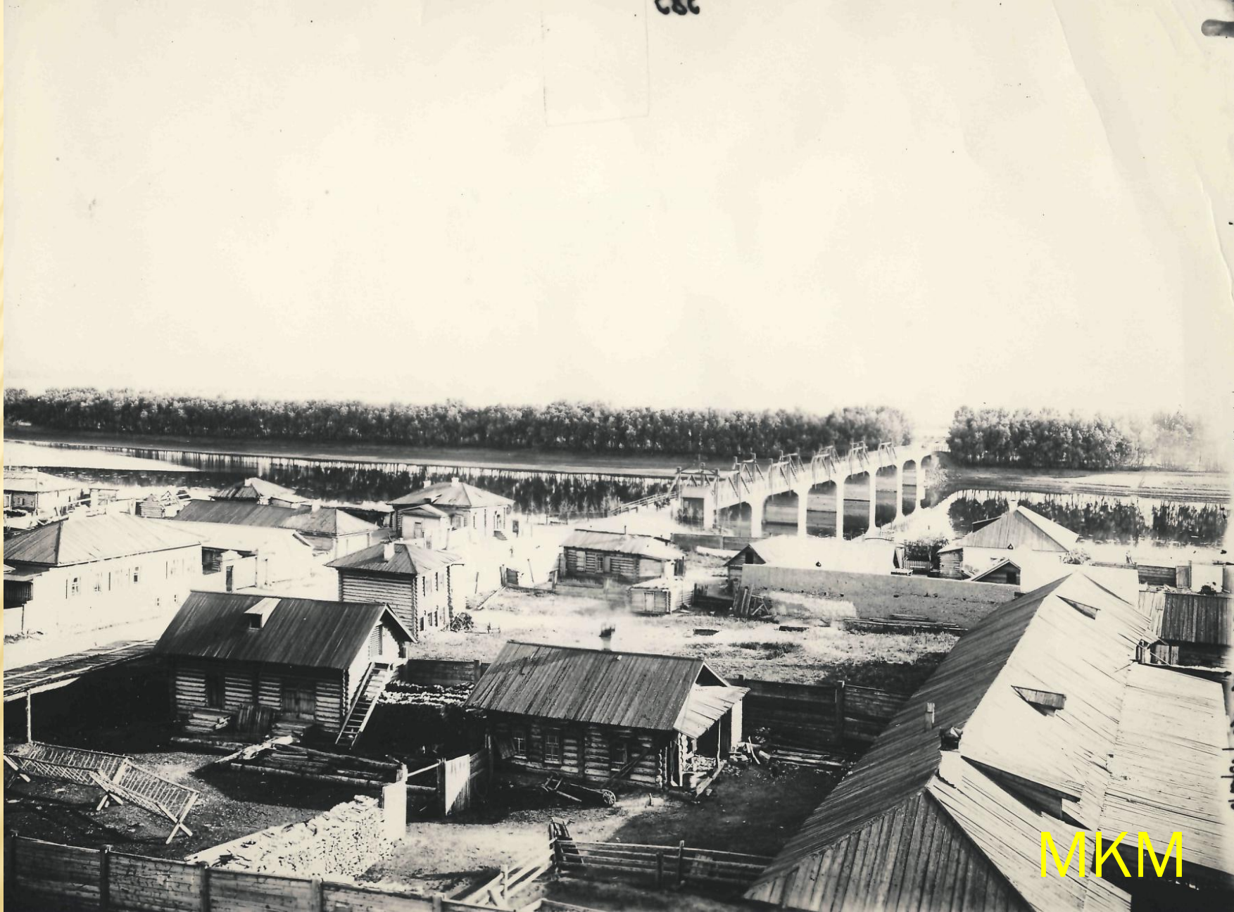
Мост через протоку Енисея. н. XX в.
