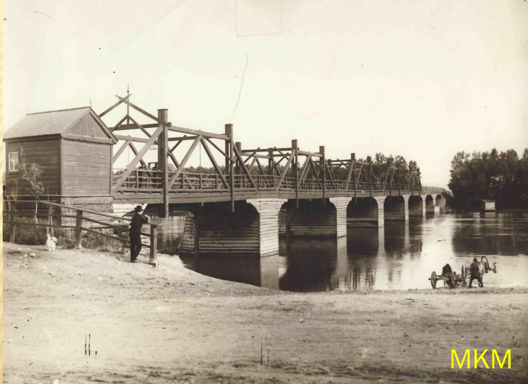
Мост через протоку Енисея. н. XX в.
